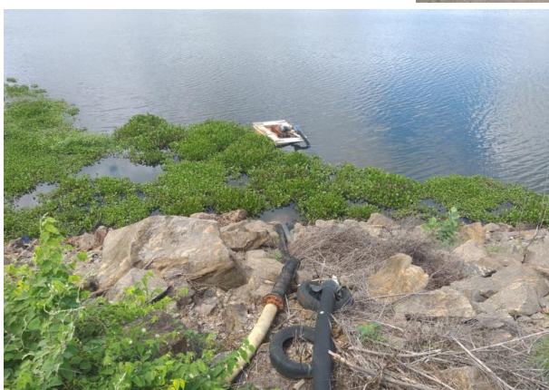
FOTO 3.3 - Captação flutuante situada na margem direita do reservatório, acoplada a tubulação flexível com DN 100 mm.
