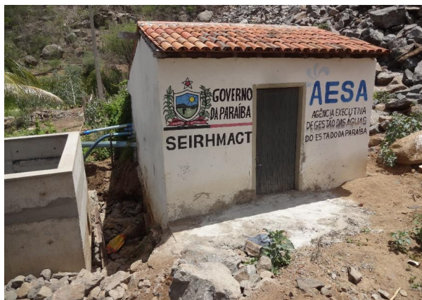
FOTO 3.8 - Casa de Controle da descarga de fundo e da captação localizada a jusante da barragem.
