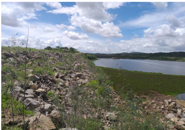
FOTO 3.1 - Vista do maciço de montante da barragem e ao fundo a bacia de acumulação de água.
