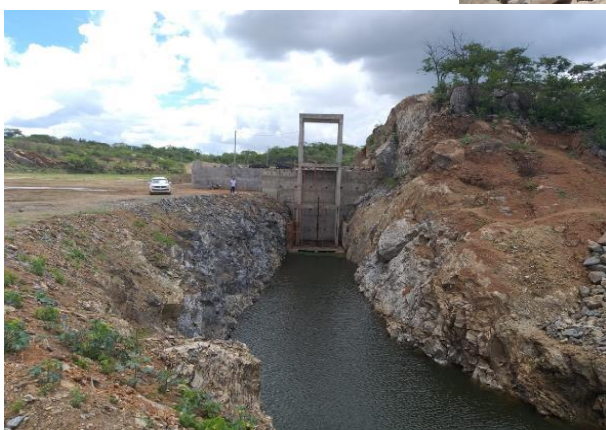
FOTO 3.9 - Vista do canal de aproximação da tomada d'água suplementar para o PISF e da torre de controle dos equipamentos hidromecânicos.
