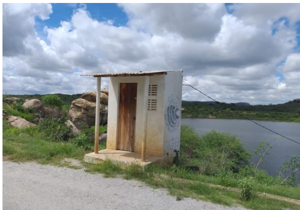
FOTO 3.4 - Casa de Controle da captação flutuante na crista da barragem.
