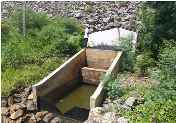
FOTO 3.7 - Estrutura de jusante de controle e saída da descarga de fundo com medidor de vazão triangular.
