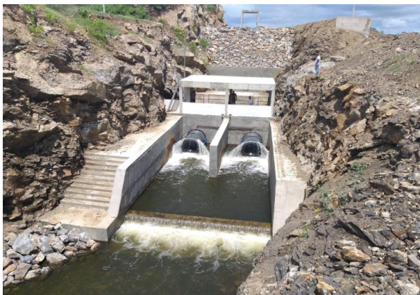
FOTO 3.10 - Vista de jusante da tomada d'água suplementar para o PISF, com duas válvulas dispersoras DN 1500 mm.
